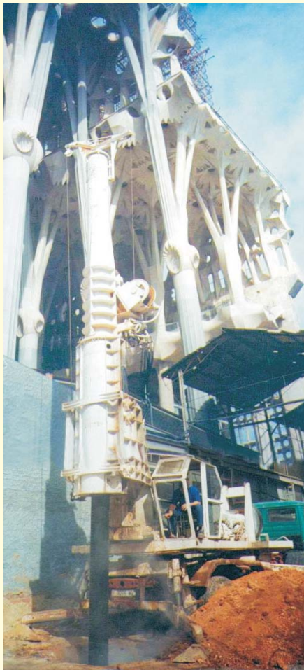
Fachada c/ Mallorca. Ejecución de pilotes CPI-7 de 125cm. de diámetro y 24 mts. de longitud.
