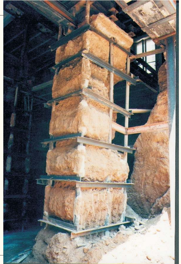
Foto 5: Nivel final de excavación.
