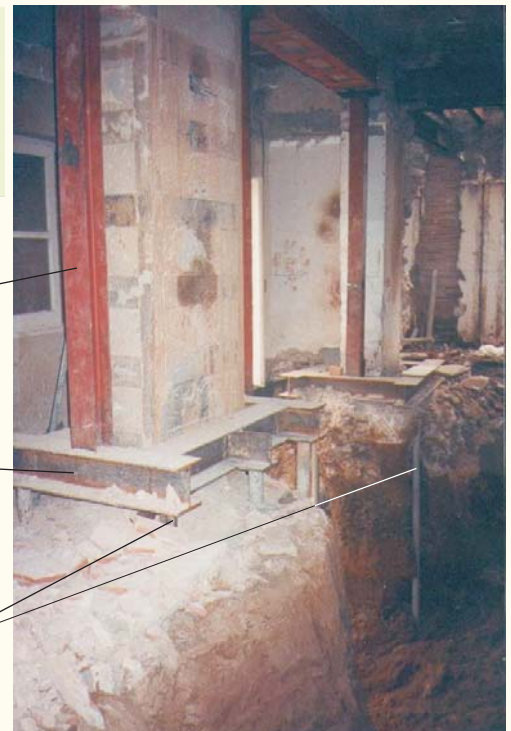
Foto 3: Excavación hasta el primer nivel de atado.
