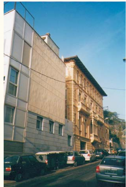
Foto 7: Estado actual del edificio
