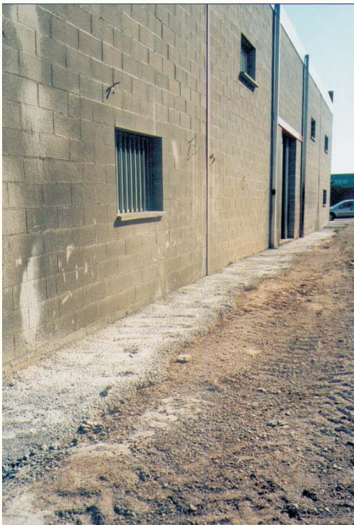
Ejecución del pavimento exterior.
