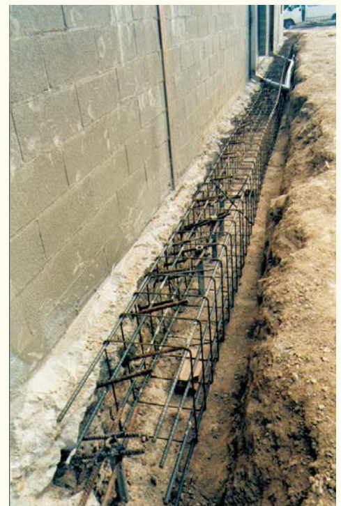
Colocación de la armadura de la nueva viga riostra perimetral y soldadura de los conectores entre ambas vigas.
