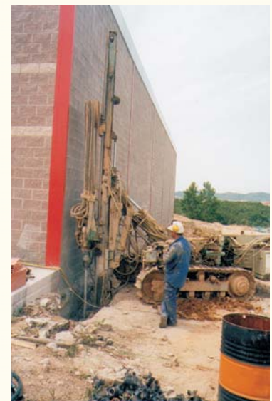
Ejecución de los micropilotes PAK'S®.
