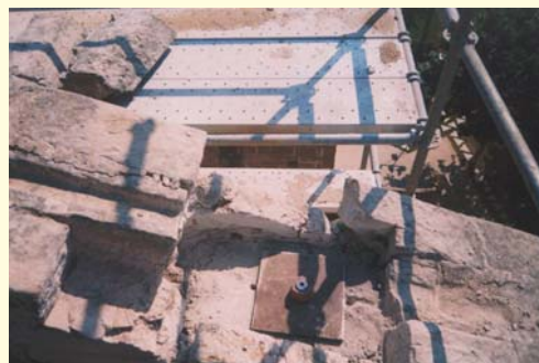
Anclaje tensado en espera de recibir la piedra de aplacado
