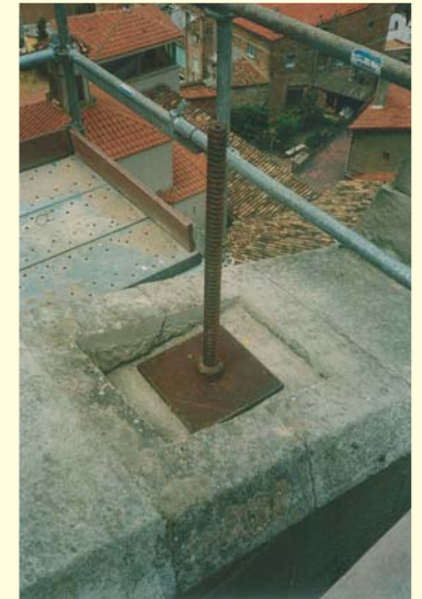
Anclaje, placa más tuerca listo para tensar
