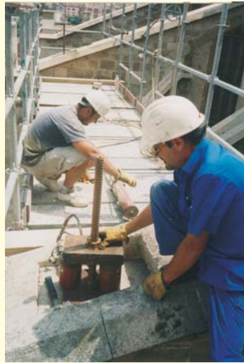
Proceso de tensado
