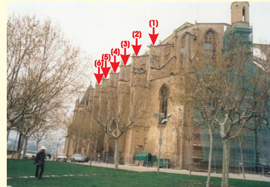
Vista de la Basílica de Santa María de Manresa. Objeto del trabajo: Anclar los contrafuertes en el terreno subyacente. Los tirantes deben llegar la cota -36.5 m desde la boca de perforación situada en el punto (1) y tensar a 10 Tn.
